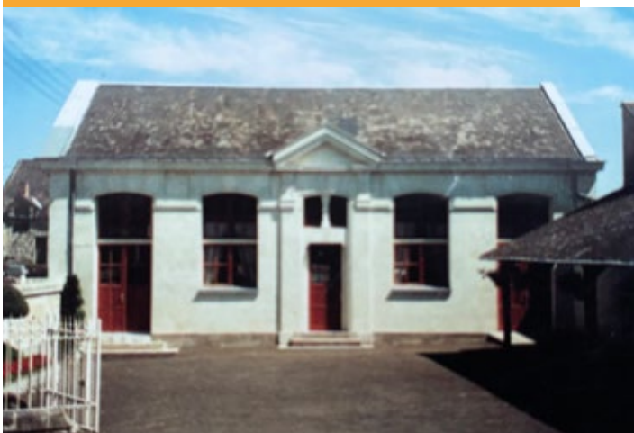
Construction de la nouvelle école de garçons en 1884.
